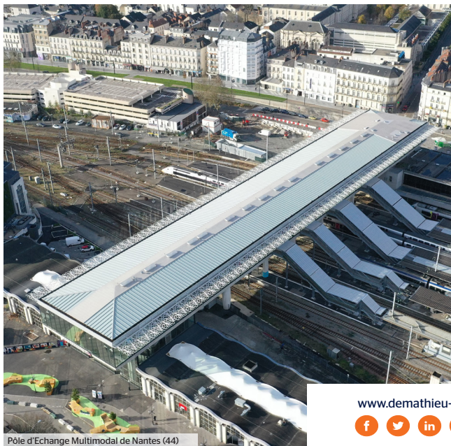
Pôle d'Echange Multimodal de Nantes (44)
